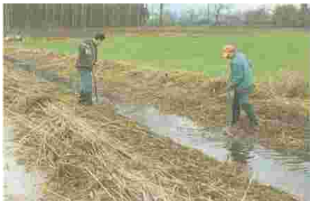
Figura 7.4: in alcune situazioni più semplici, ancor oggi la vegetazione dei canali può essere tagliata con la falce manuale(a); il processo è più costoso, ma presenta grossi vantaggi ecologici (LfU, Land Baden – Württemberg, 2000). Per facilitare le operazioni di manuali è possibile impiegare motofalciatrici con organo tagliatore rotante a fili di plastica (b). Questo attrezzo, molto duttile poiché guidato a mano, può essere utilizzato per lo sfalcio di fasce spondali e scarpate dei canali.
