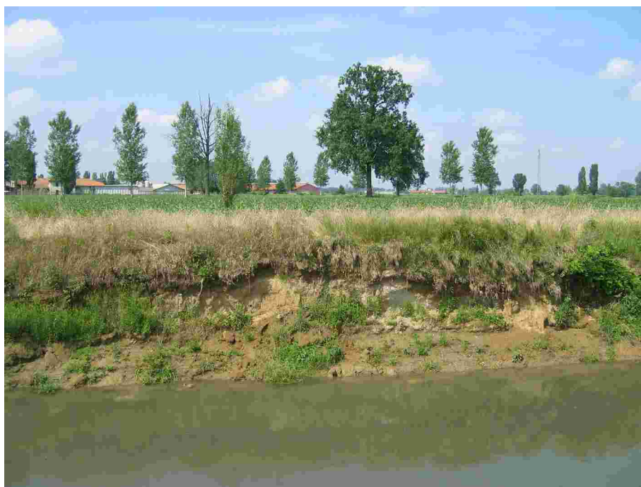
Figura A.12: cedimento di sponda.
