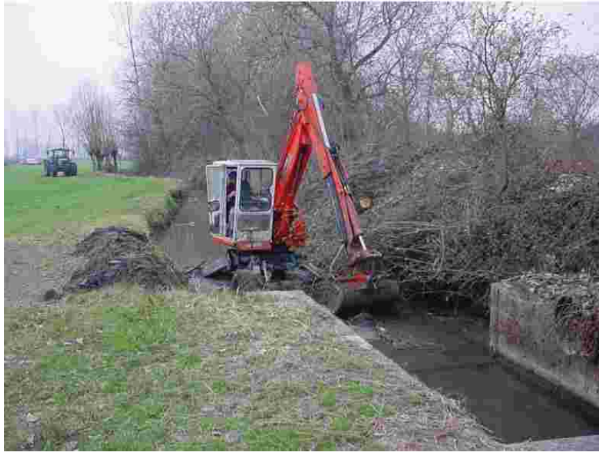
Figura 7.10: escavatore a cucchiaio, montato su un veicolo tipo “ragno”, che lavora frontalmente per lo spurgo di una sezione “critica” (Foto CBI Muzza Bassa Lodigiana).
