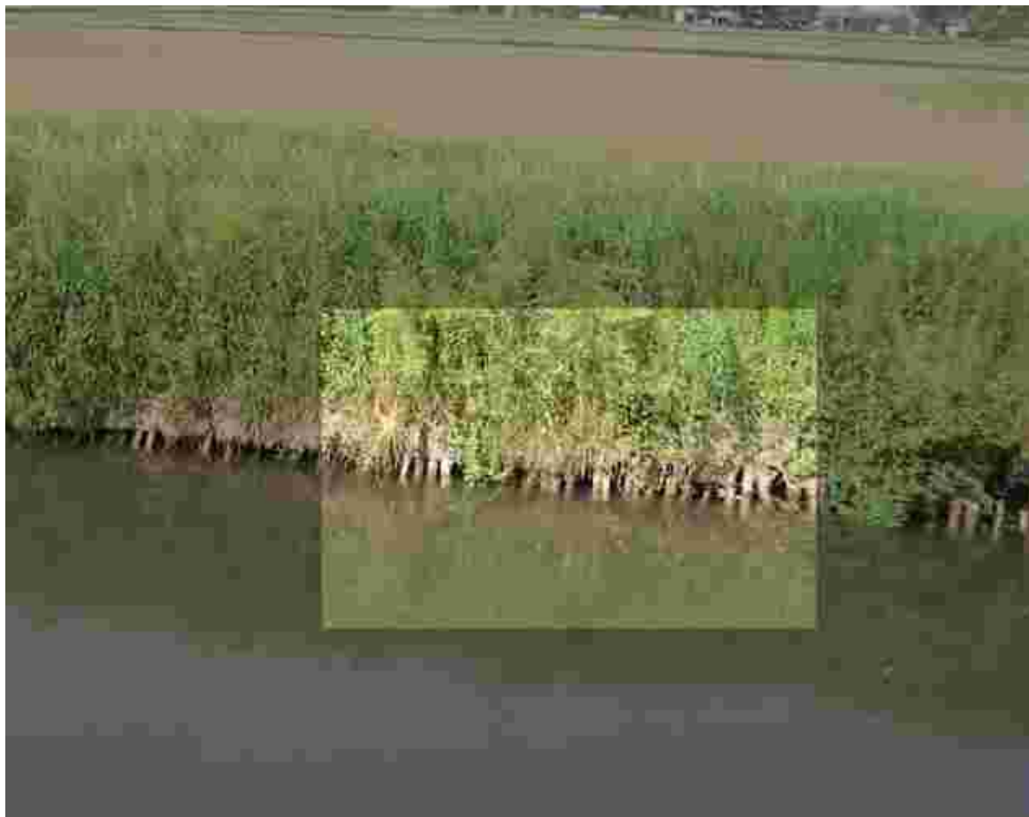
Figura 4.7: al piede della sponda è opportuno prevedere la posa di un'ulteriore protezione per evitare il dilavamento del suolo prima della completa radicazione delle talee (foto C.B. Naviglio Vacchelli e Naviglio della città di Cremona).
